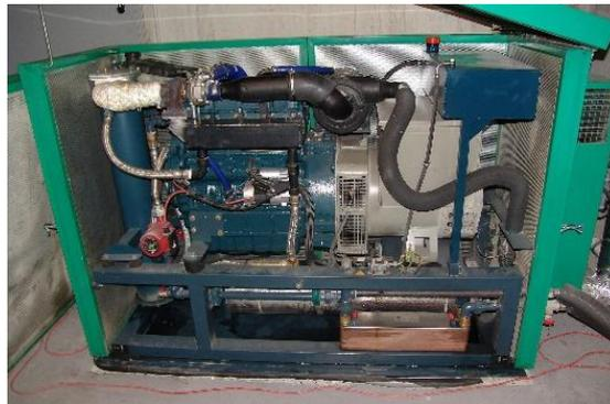
*Abbildung 7: Darstellung eines Blockheizkraftwerkes*
